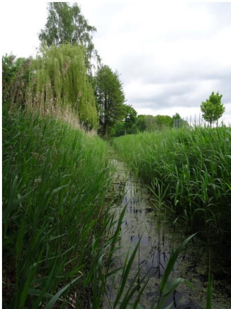
25.05.21: Entwässerungsgraben, Blickrichtung Nord
