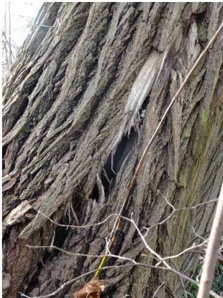
Riss Stammfuß Baum Nr. 4
