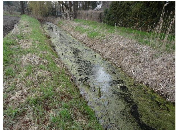
25.03.2021: Entwässerungsgraben mit Bewuchs der kleinen Wasserlinse, Blickrichtung West- Südwest
